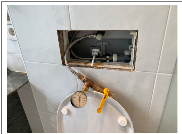
Bilder 5 und 6 – Top 17 Druckprobe KW und WW
