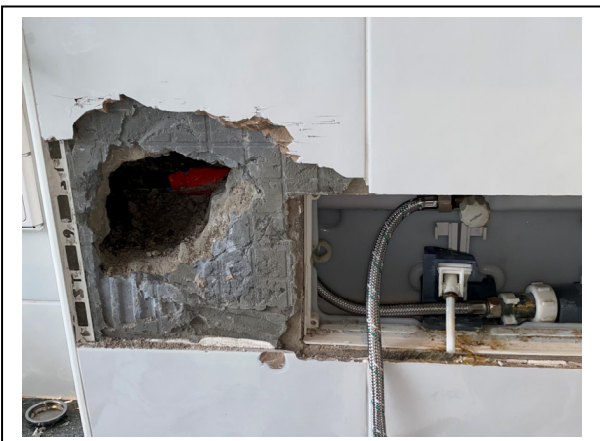
Bild 11 – Top 17 Freigelegter Rohrbruch
