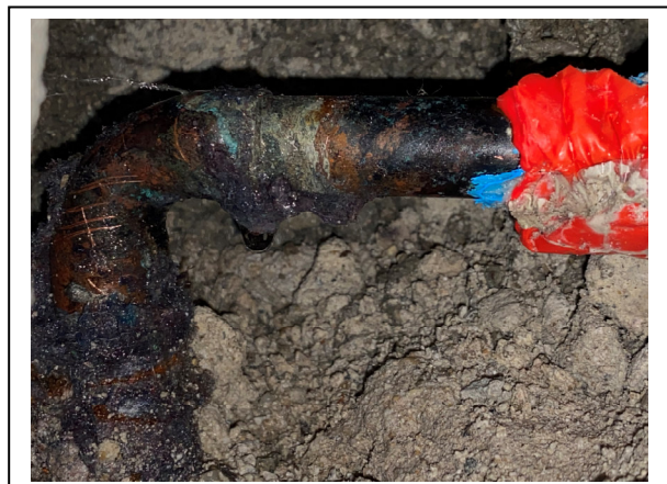
Bild 12 – Top 17 Die Bruchstelle in der KW Leitung
